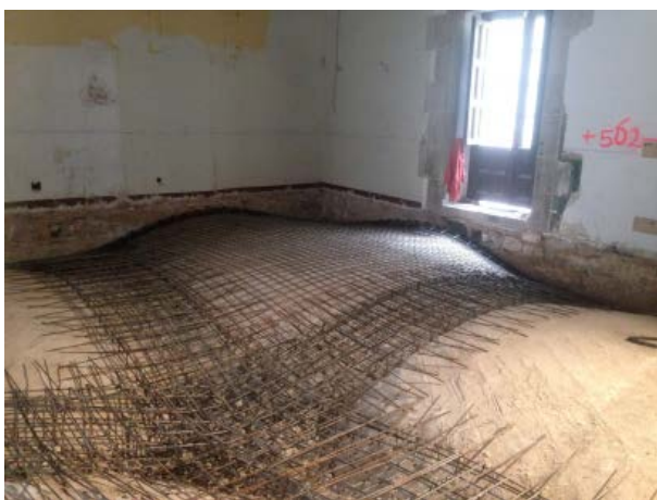
Reforç de forjats
