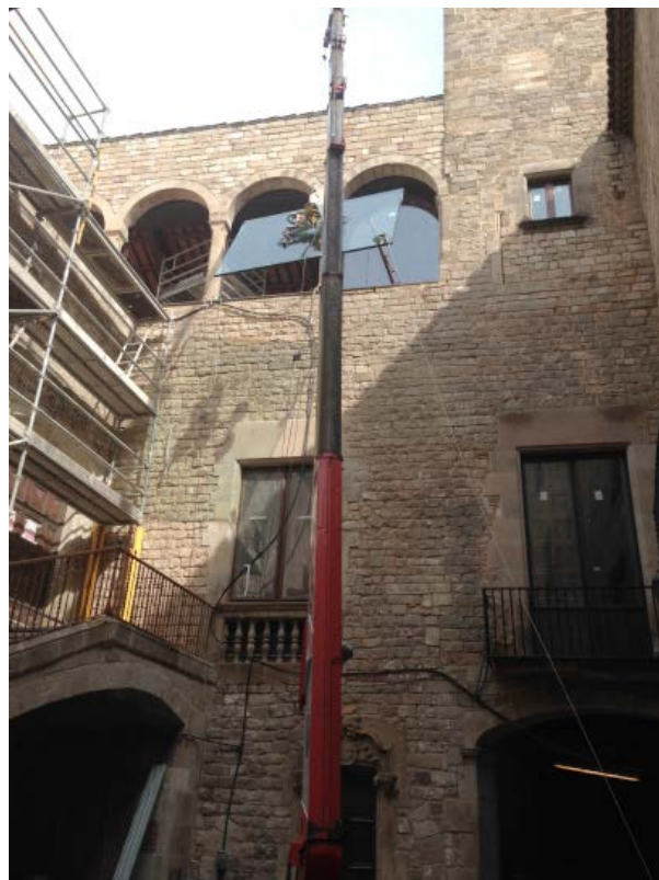
Col·locació de vidres
